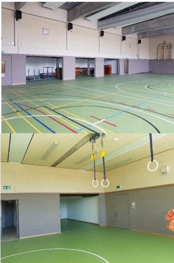
Sanierung Sporthallen Schule Flonheim, 2020
