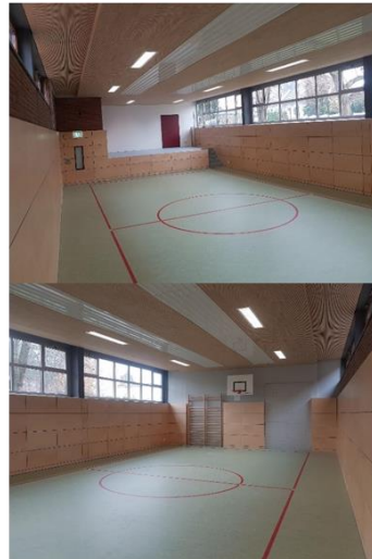
Sanierung Sporthalle Schule Albig, 2022
