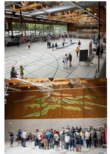
Sanierung Petersberghalle Gau-Odernheim, 2023
