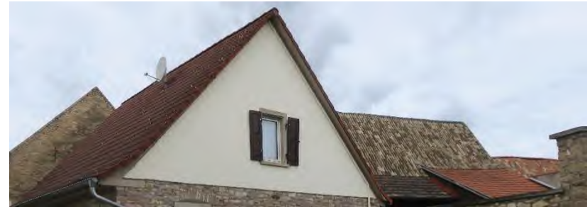
Backhausgasse: Beispiel für die Dachstruktur
