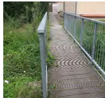
Überquerung des Dunzelbachs hinter dem Gemeinschaftshaus
