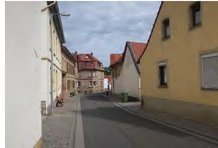
Hauptstraße mit Blick Richtung Wöllsteiner Straße
