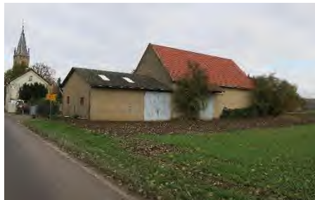
Südlicher Ortsrand (alter Ortskern)
