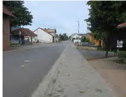
Wöllsteiner Straße mit Blick Richtung Ortsausgang Wöllstein
